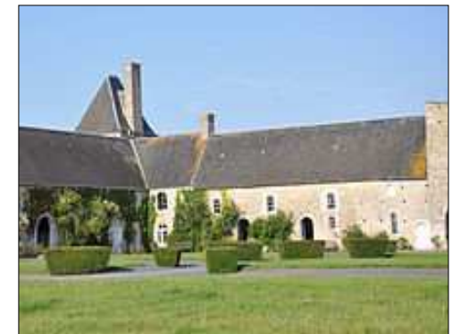
L'ensemble d'habitation situé dans le prolongement du grand salon
